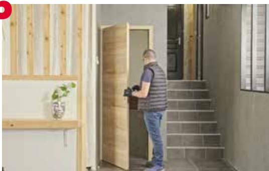
Installation du vantail et vérification des jeux de fonctionnement
