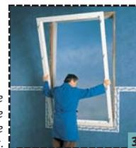
Ajustement parfait sur le bâti grâce aux vérins réglables et fixation par vis.
