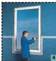
Après les opérations de réglages et d'étanchéité, mise en place des vantaux de la nouvelle fenêtre.
