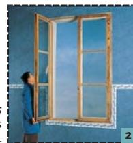
Mise en place de la nouvelle fenêtre sur le bâti existant.
