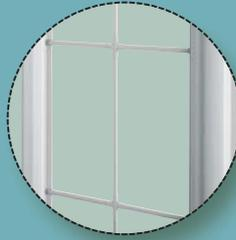
PETITS PROFILS ALUMINIUM LAQUÉS BLANC OU SABLE INTÉGRÉS DANS LE DOUBLE VITRAGE.
